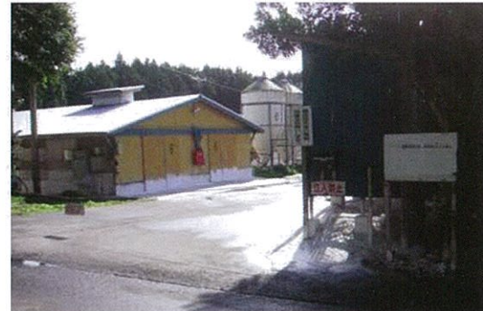
消石灰帯の設置
