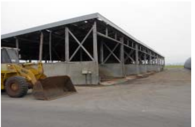
柱や梁に古電柱を使用し、設備コストの低減 ・ショベルローダー 切り返しや積み込み作業
