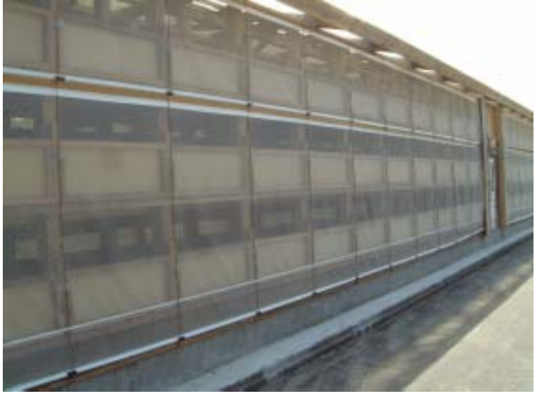
発酵舎内の悪臭を低減させるため、攪拌機に消臭剤の散布装置を装備すると共に建屋内で吸引した臭気を側面に設置したおがくず脱臭装置を通過させ悪臭の低減を図っている。
