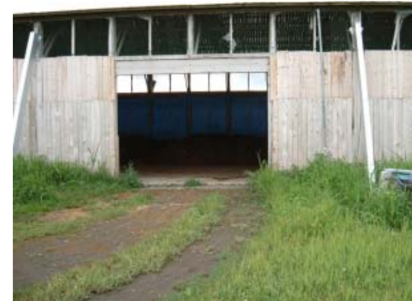
入口右に設置しているタンクの水を利用し、水分調整している。
