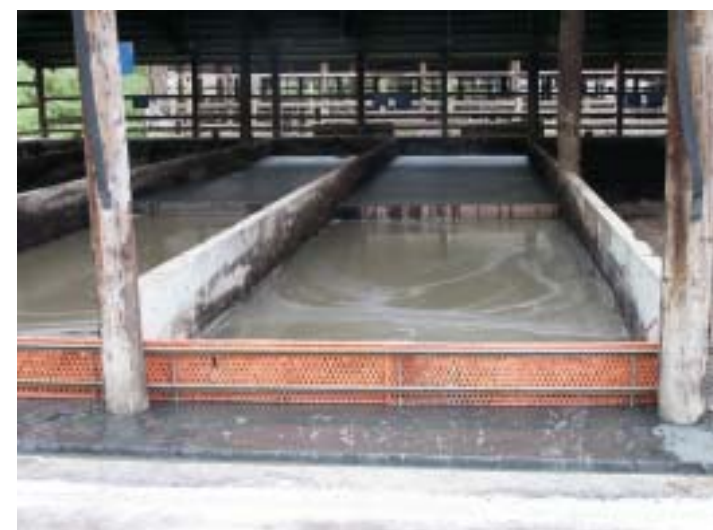
止水板を工夫した固液分離の様子。このように固液分離した後に12槽(1槽20m3)の尿処理槽に移動して処理される。
